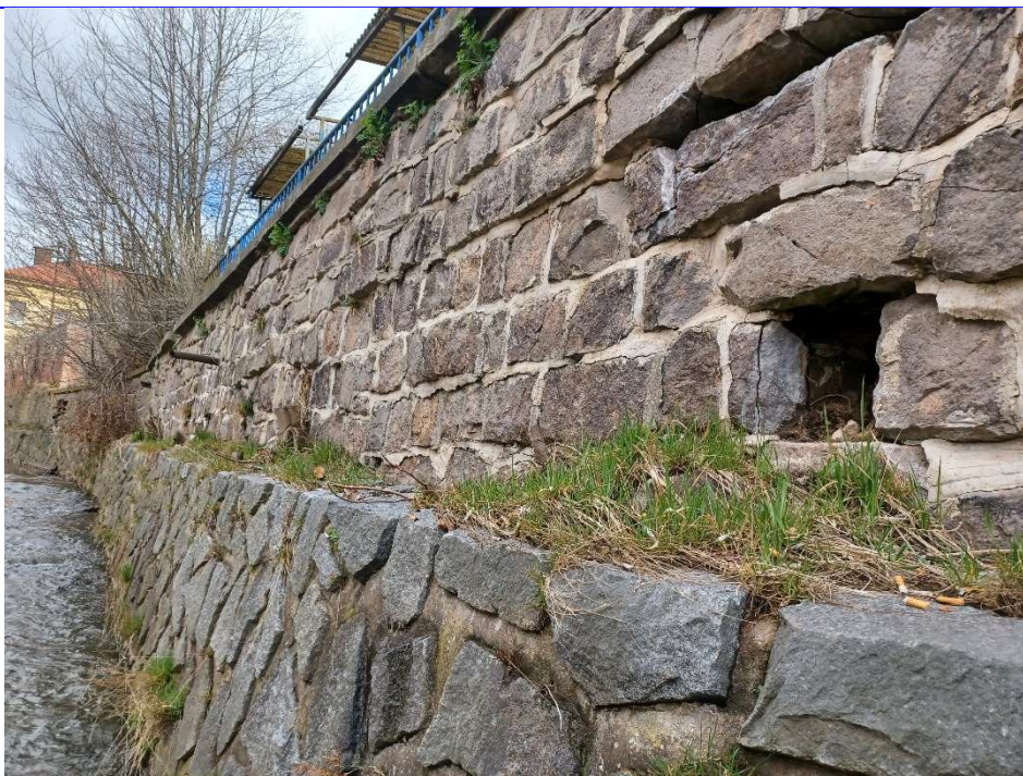
Obrázek 1.3: Detail nábrežní zdi u objektu parc. č. st. 543 Soukenická č.p. 64 a řekou, pohled proti vodě; původní kamenná zeď s lícem z řádkového zdiva, přízdívka paty zdi s použitím žulového kamene.
