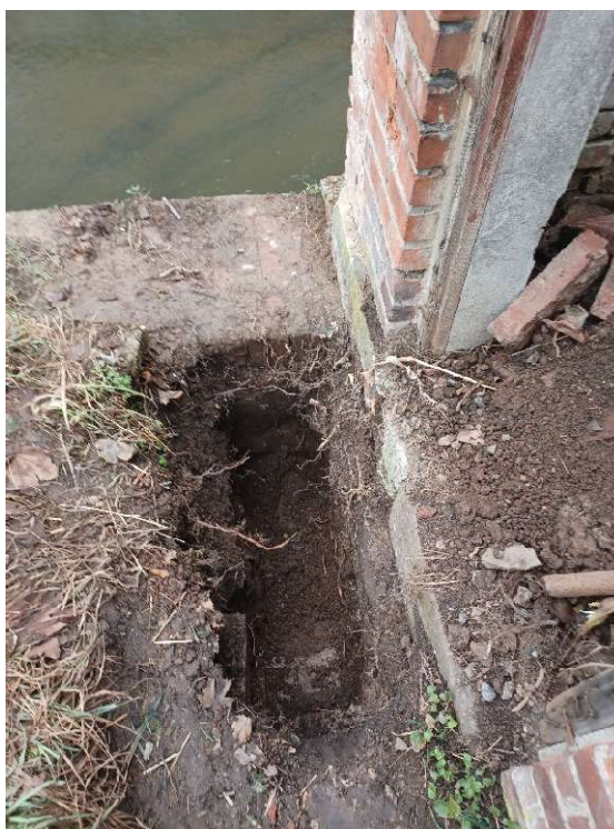
Obrázek 3.6: Celkový pohled na sondu mezi rubem nábrežní zdi a objektem parc. č. st. 552.
