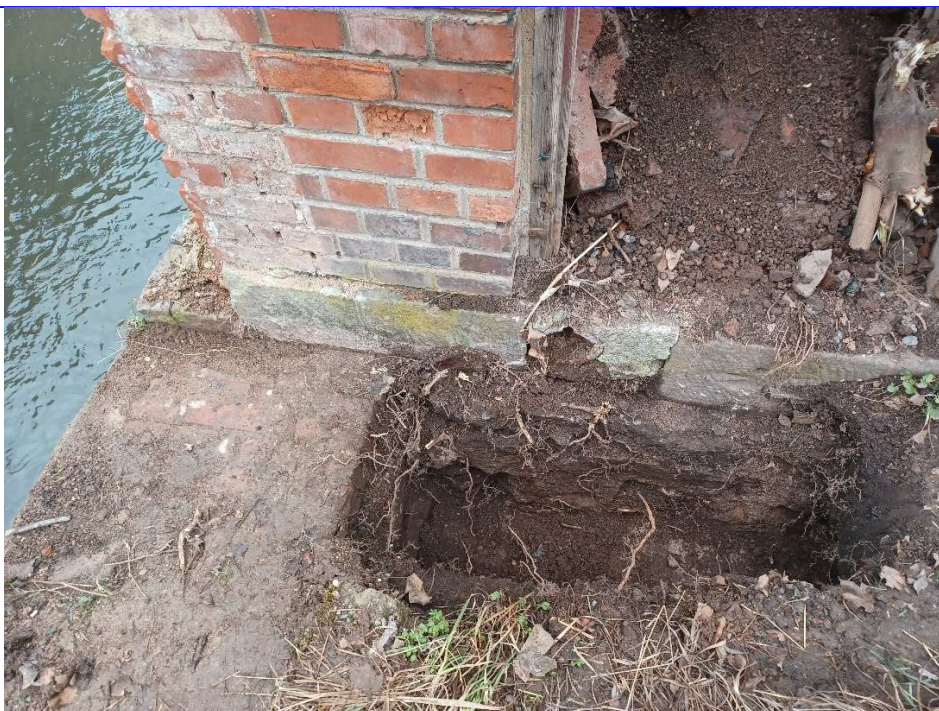
Obrázek 3.7: Pohled na roh objektu parc. č. st. 552, který je z části uložený na rubu průběžné nábrežní zdi.
